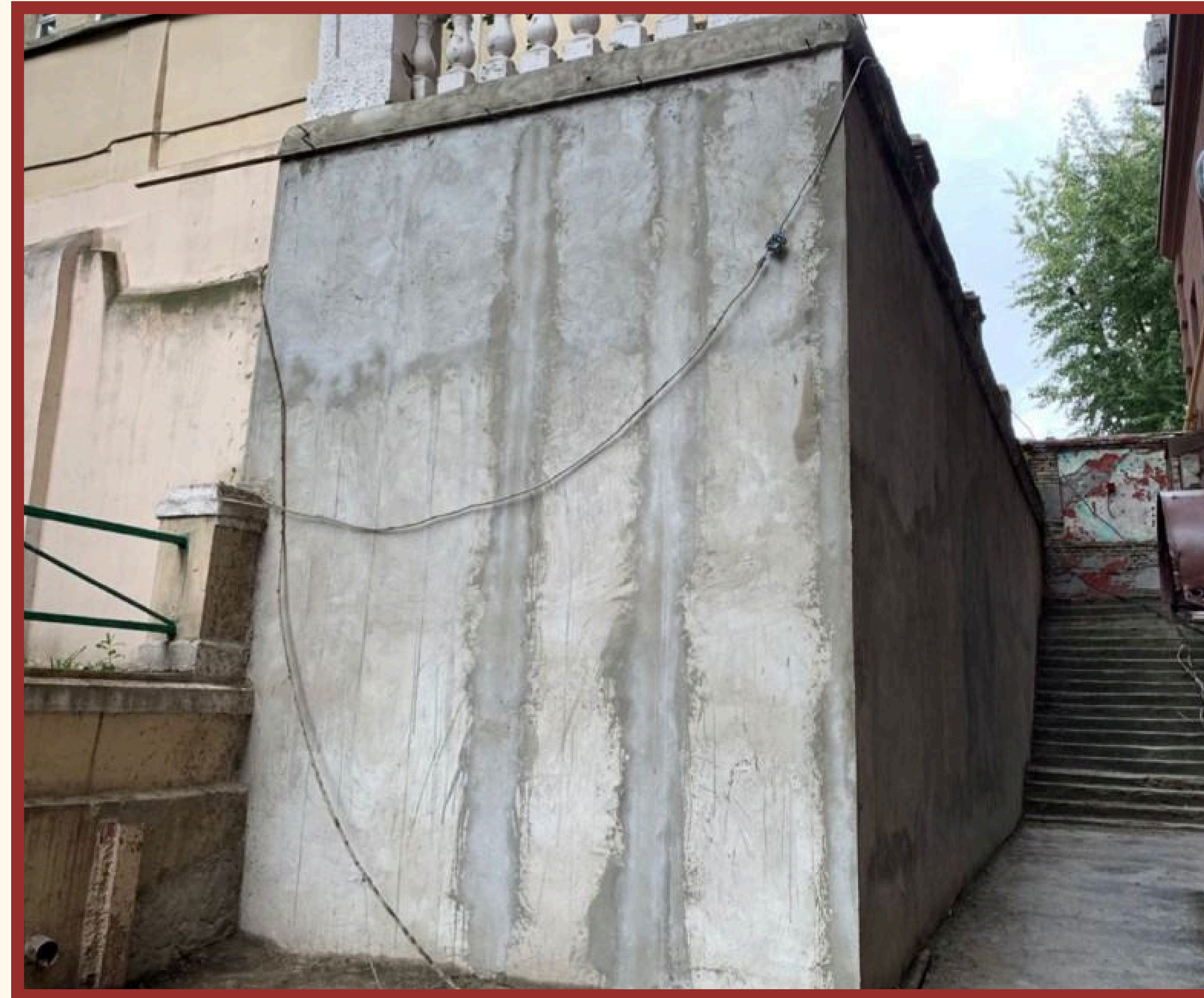
ЗЕМЛЯНОЙ ВАЛ, 46: ПОДПОРНАЯ СТЕНА
